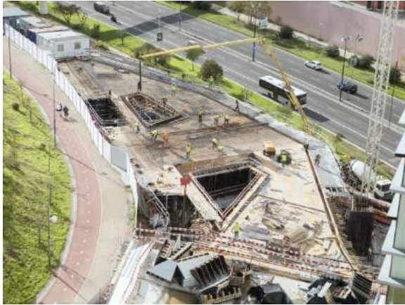
(b) Vista aérea da frente de obra do Bloco A+B
