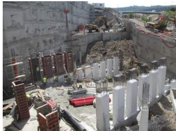
(b) Pilares do auditório (fase construtiva).
