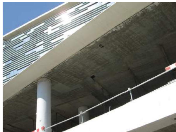
Figura 11. Zona exterior em betão branco e zona interior em betão corrente.
