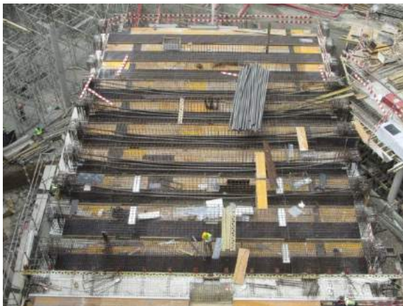
(c) Vigas do auditório (fase construtiva).
