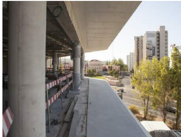
(e) Vista aproximada de palas de betão branco
