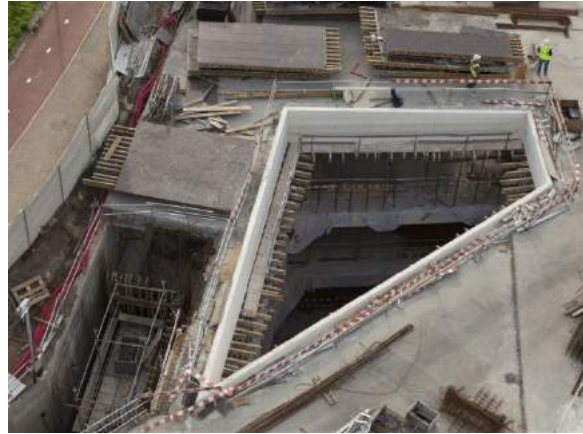
(c) Vigas em betão branco e laje em betão corrente
