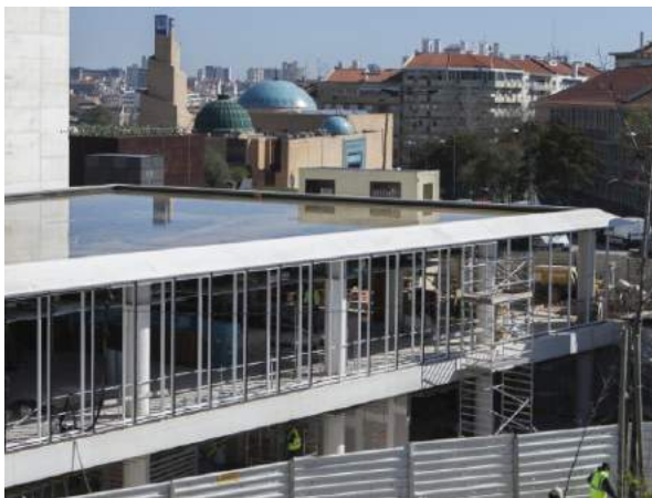
(d) Vista do Bloco C
