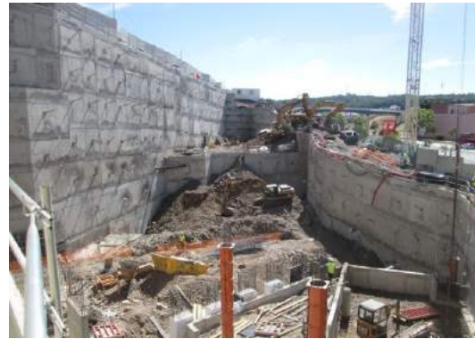
Figura 2. Escavação e Contenção no Bloco A+B
